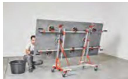
L'obiettivo da perseguitare è lo strato compatto di adesivo, senza vuoti d'aria. Stendere l'adesivo con la tecnica della doppia spalmatura. L'adesivo deve essere spalmato, con idonee spatole, sempre parallelo al lato corto sia sulla lastra con spatola minima dente 3x3, che sul fondo su cui va applicata con spatola minima dente 10x10.
